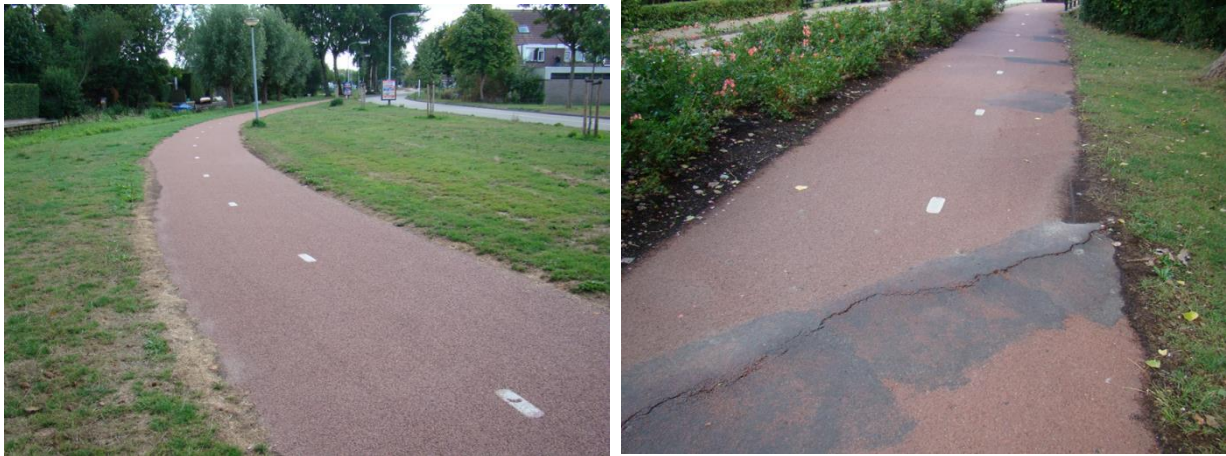
Afbeelding 8 en 9: Fietspad met gemodificeerd kleurloos bindmiddel aangelegd in 2005. Afgezien van wortel en randschade verder geen schade in 2019.
