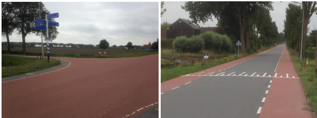
Afbeelding 6 en 7: Rood asfalt met gemodificeerd kleurloos bindmiddel. Afgezien van randschade verder geen schade in 2019.
