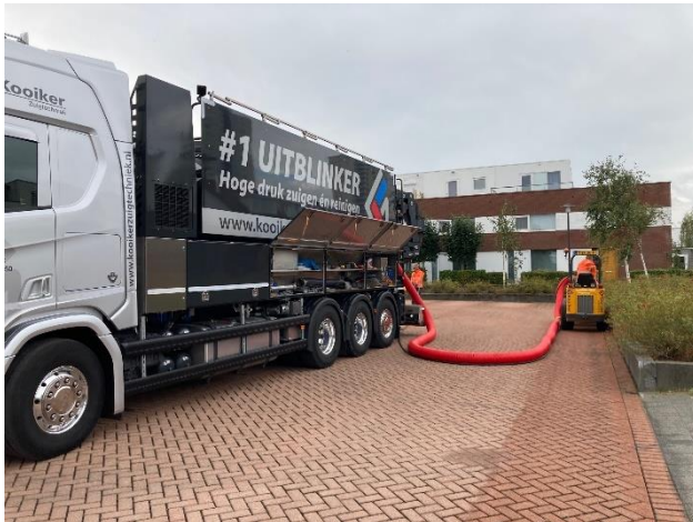
Figuur 5: Zoab cleaner aan het werk in Nesselande
