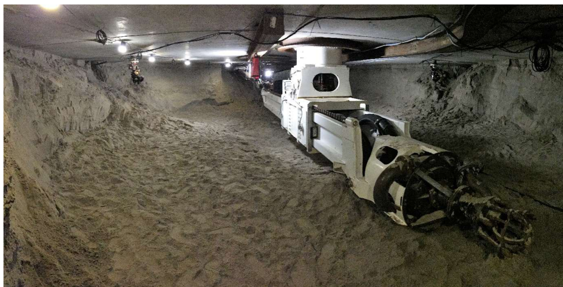
Fig. 3 Impressie van één van de twee werkkamers in het caisson van de binnendeurkas na installatie (pomp (zonder snijkop) aan de baggerarm, camera (rechts), waterjets en ondersteunende grondbermen (foto: VSF)
