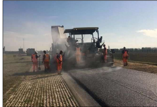
Figuur 4. Vrijkomende dampen tijdens asfaltering
