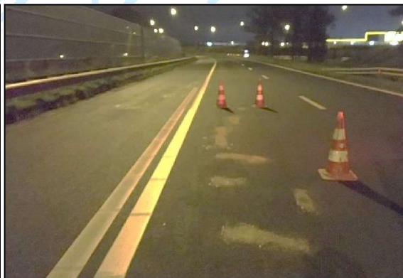
Figuur 2. Eerste tekenen van schade (reparatie) in jonge deklagen
