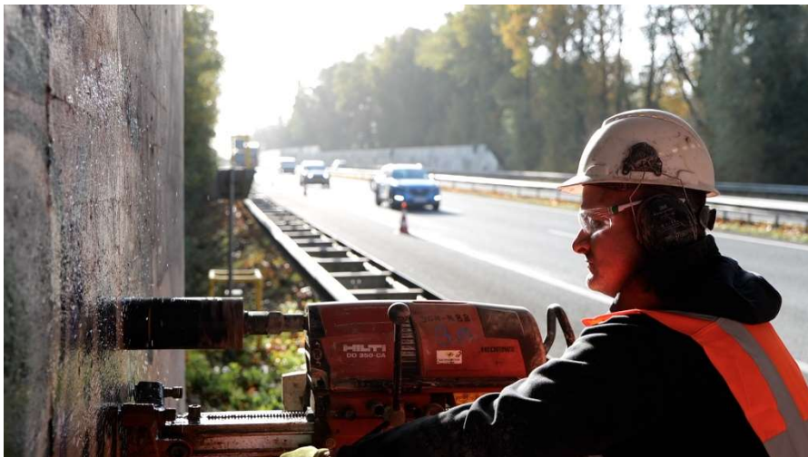
Figuur 2: Kernen worden geboord ten behoeve van restlevensduuranalyses
