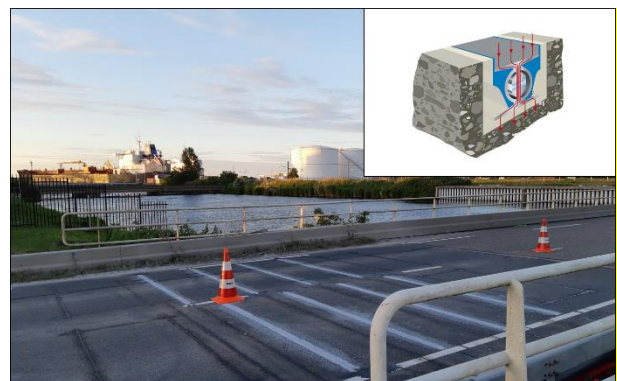
Figuur 2: WIM-ROAD Noord systeem bestaat uit 8 Lineas quartz sensoren (rechtsboven) per rijstrook met 4 sensoren per wiel om de hoogst mogelijke nauwkeurigheid te bereiken.
